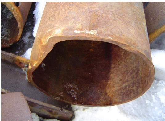
図 4.2-7 ゲージポール破損
